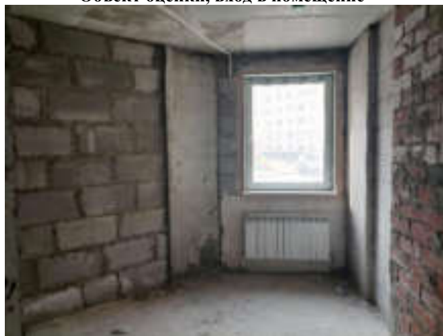
Фото 6. Внутреннее состояние помещения
