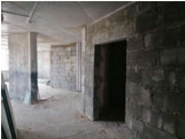
Фото 7. Внутреннее состояние помещения
