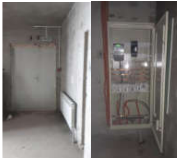
Фото 8. Внутреннее состояние помещения
