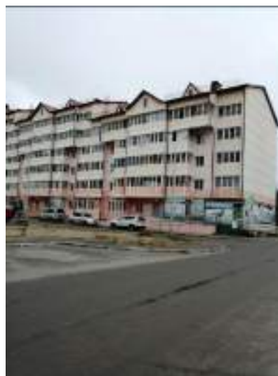
Фото 2. Внешний вид здания, в котором расположены объекты №1-4
