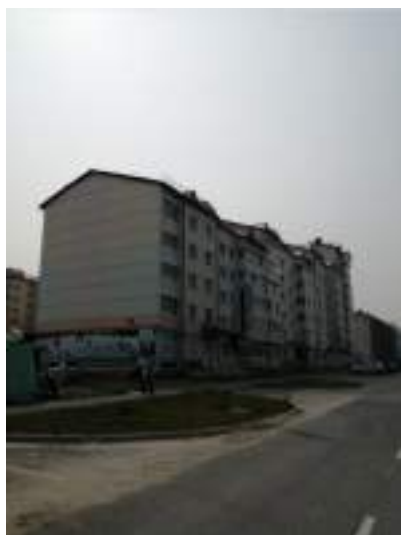
Фото 1. Внешний вид здания, в котором расположены объекты №1-3
