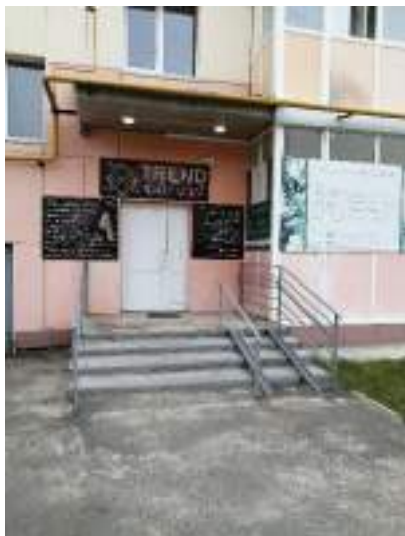
Фото 3. Вход в помещение №1
