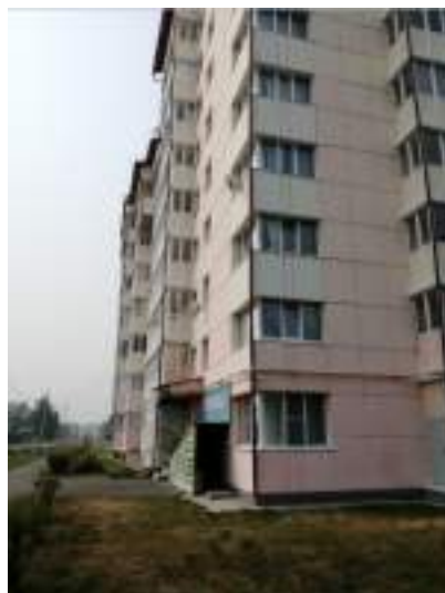
Фото 31. Внешний вид здания, в котором расположены объекты №4,5
