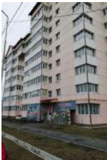
Фото 30. Внешний вид здания, в котором расположены объекты №4,5
