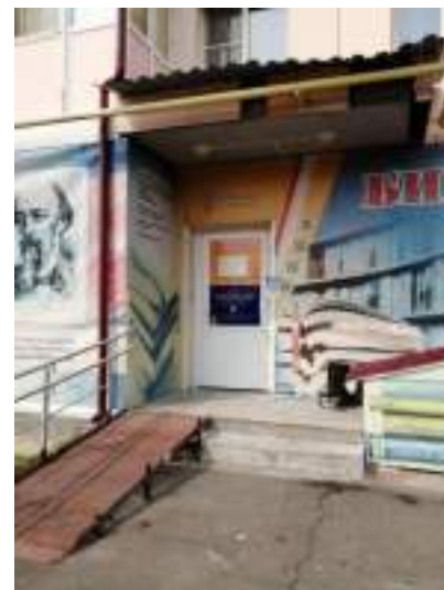
Фото 32. Вход в помещение №4
