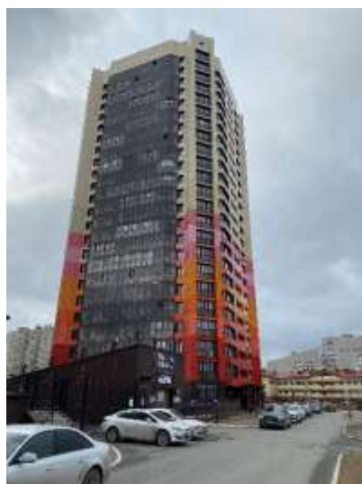
Фото 1. Внешний вид дома, в котором расположено помещение
