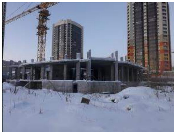
Фото. 2. Состояние строительной готовности корпуса № 7
