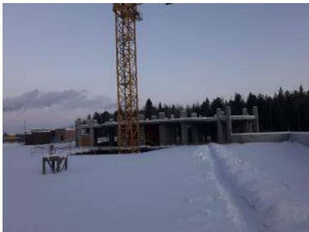
Фото. 1. Состояние строительной готовности корпуса № 7
