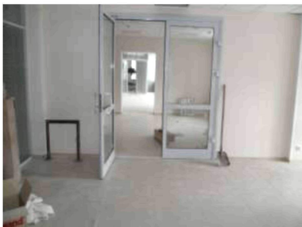
Фото 11. Внутренний вид помещения
