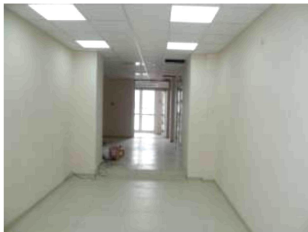
Фото 6. Внутренний вид помещения
