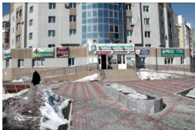
Фото 1. Вид жилого дома
