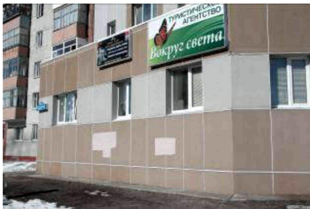
Фото 3. Вид жилого дома
