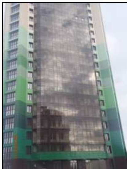
Фото 1. Внешний вид дома
