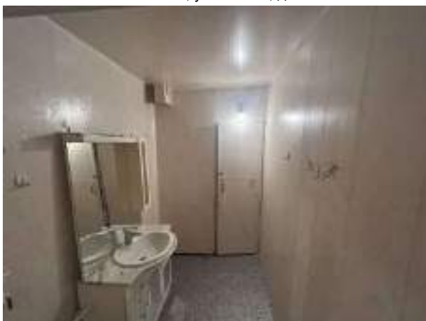
Фото. 37. Внутренний вид квартиры по адресу: г. Ханты-Мансийск, ул. Чехова, д. 62
