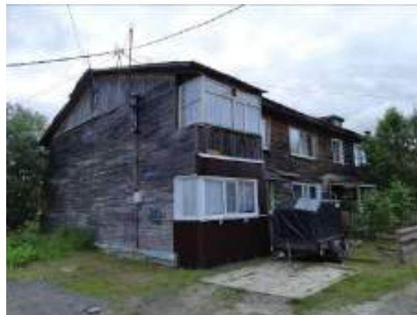
Фото. 2. Жилой дом по адресу: г. Ханты-Мансийск, ул. Чехова, д. 66а
