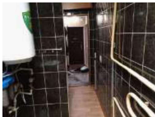
Фото. 8. Внутренний вид квартиры по адресу: г. Ханты-Мансийск, ул. Чехова, д. 66а, кв. 10
