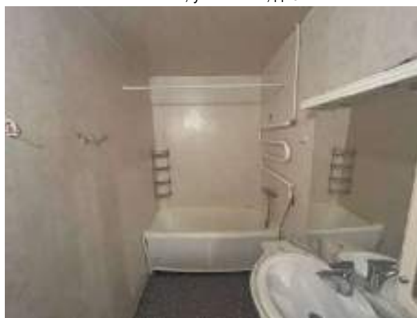
Фото. 36. Внутренний вид квартиры по адресу: г. Ханты-Мансийск, ул. Чехова, д. 62
