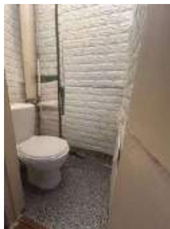
Фото. 38. Внутренний вид квартиры по адресу: г. Ханты-Мансийск, ул. Чехова, д. 62
