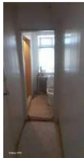
Фото. 22. Внутренний вид квартиры по адресу: г. Ханты-Мансийск, ул. Калинина, д. 30, кв. 10
