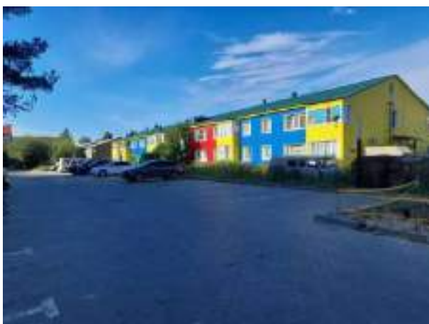
Фото. 25. Жилой дом по адресу: г. Ханты-Мансийск, ул. Чехова, д. 62
