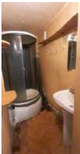
Фото. 21. Внутренний вид квартиры по адресу: г. Ханты-Мансийск, ул. Калинина, д. 30, кв. 10
