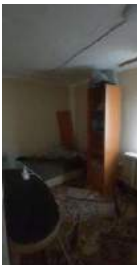
Фото. 16. Внутренний вид квартиры по адресу: г. Ханты-Мансийск, ул. Калинина, д. 30, кв. 10
