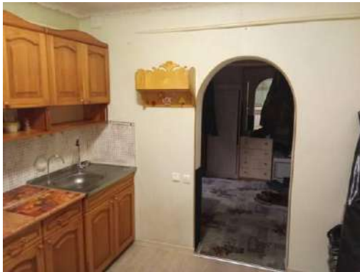
Фото. 11. Внутренний вид оцениваемой квартиры
