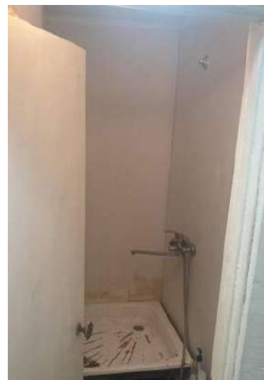
Фото. 5. Внутренний вид оцениваемой квартиры
