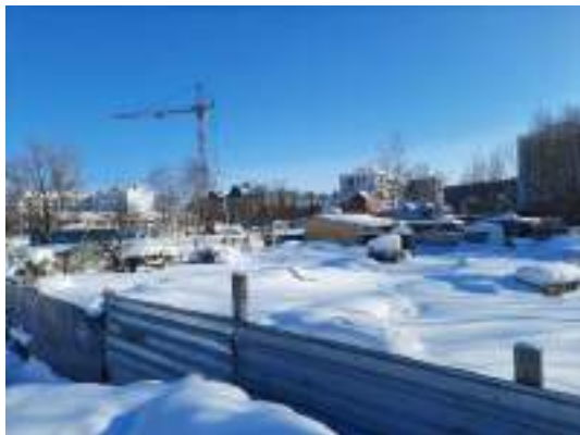
Фото 3. Общий вид земельного участка, кадастровый номер: 86:12:0101058:4
