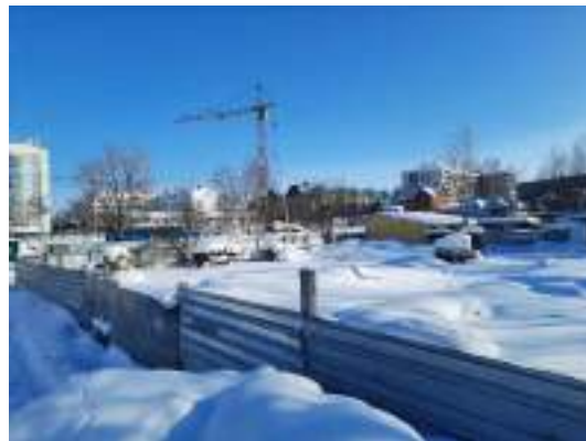
Фото 4. Общий вид земельного участка, кадастровый номер: 86:12:0101058:4
