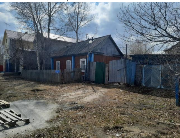
Фото 5. Общий вид дома с кадастровым номером 86:12:0101044:284
