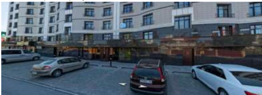
Фото 35 Общий вид оцениваемых помещений.
