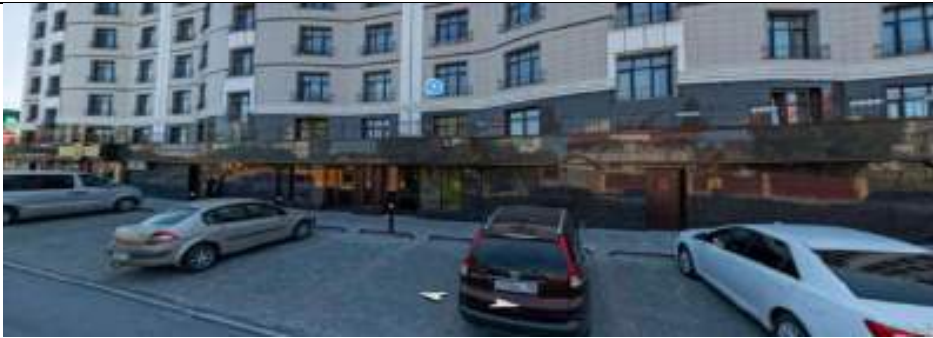
Фото 37 Общий вид оцениваемых помещений.
