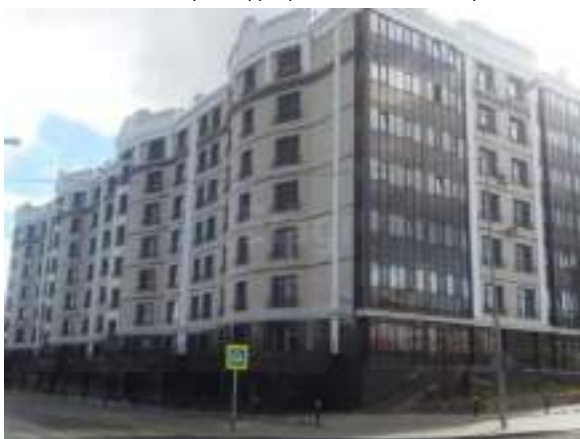
Фото 36 Общий вид жилого дома, в котором находятся оцениваемые помещения
