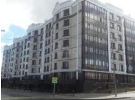
Фото 38 Общий вид жилого дома, в котором находятся оцениваемые помещения
