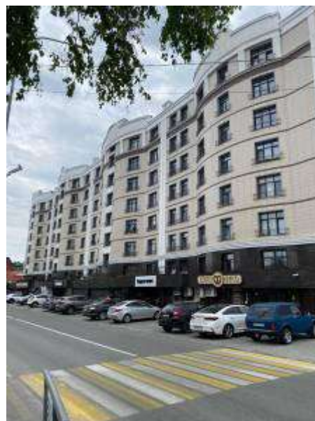
Фото 2. Внешний вид здания
