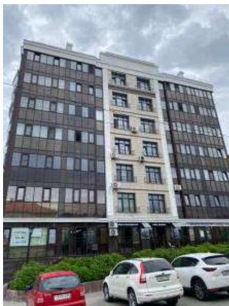
Фото 1. Внешний вид здания
