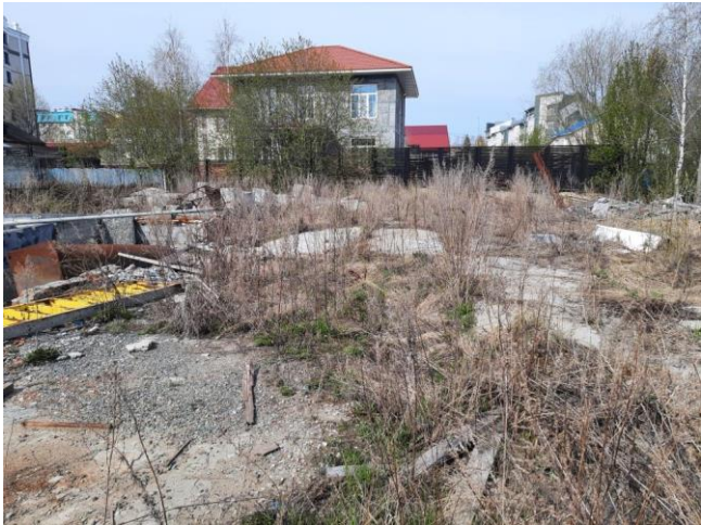
Фото 3. Общий вид земельного участка с кадастровым номером 86:12:0101058:6.
