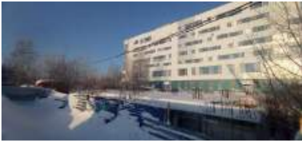
Фото 8. Общий вид объекта незавершенного строительства кадастровый номер: 86:12:0101059:30
