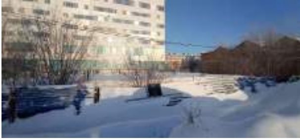
Фото 10. Общий вид объекта незавершенного строительства кадастровый номер: 86:12:0101059:30
