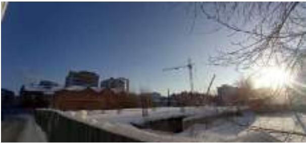
Фото 7. Общий вид объекта незавершенного строительства кадастровый номер: 86:12:0101059:30
