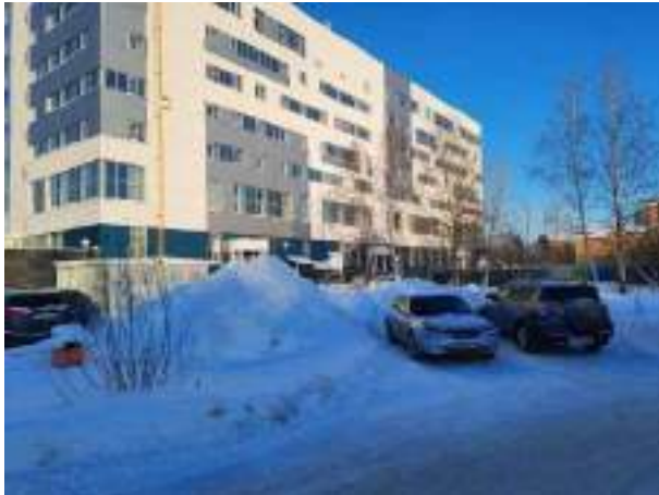
Фото 1. Общий вид земельного участка кадастровый номер: 86:12:0101058:3
