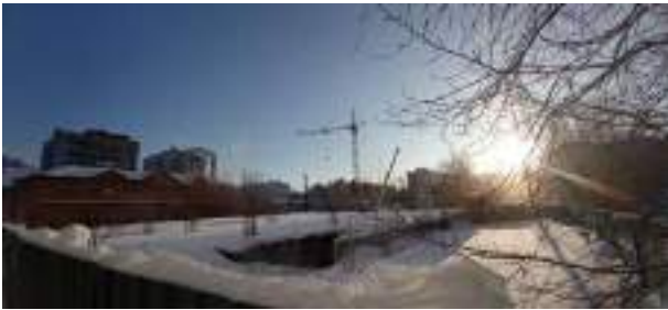
Фото 13. Общий вид объекта незавершенного строительства кадастровый номер: 86:12:0101059:30
