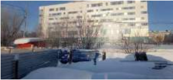
Фото 11. Общий вид объекта незавершенного строительства кадастровый номер: 86:12:0101059:30
