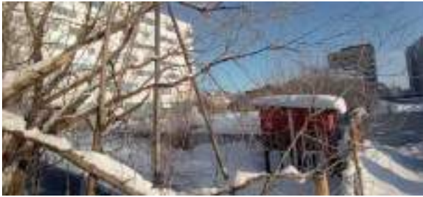
Фото 12. Общий вид объекта незавершенного строительства кадастровый номер: 86:12:0101059:30
