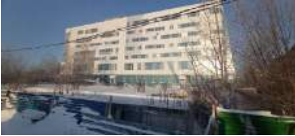
Фото 9. Общий вид объекта незавершенного строительства кадастровый номер: 86:12:0101059:30
