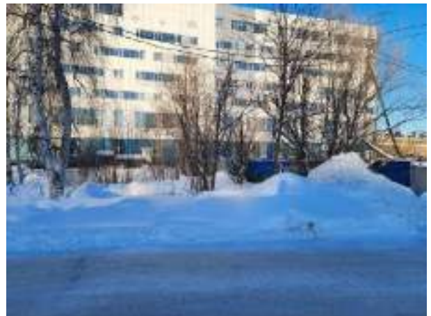
Фото 6. Общий вид земельного участка кадастровый номер: 86:12:0101058:3
