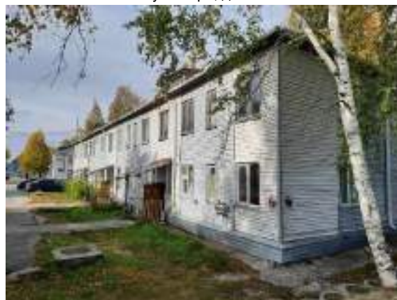
Фото. 18. Жилой дом по адресу: г. Ханты-Мансийск, ул. Мира, д. 25
