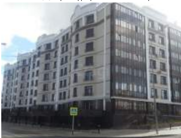
Фото 20 Общий вид жилого дома, в котором находятся оцениваемые помещения
