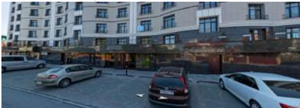
Фото 19 Общий вид оцениваемых помещений.
