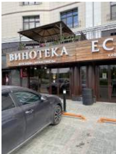
Фото 21. Вид на помещение 1007 с улицы
