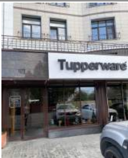
Фото 5. Вид на помещение 1002 с улицы
