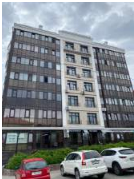
Фото 1. Внешний вид здания
