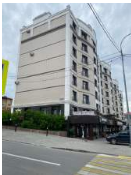
Фото 3. Внешний вид здания
