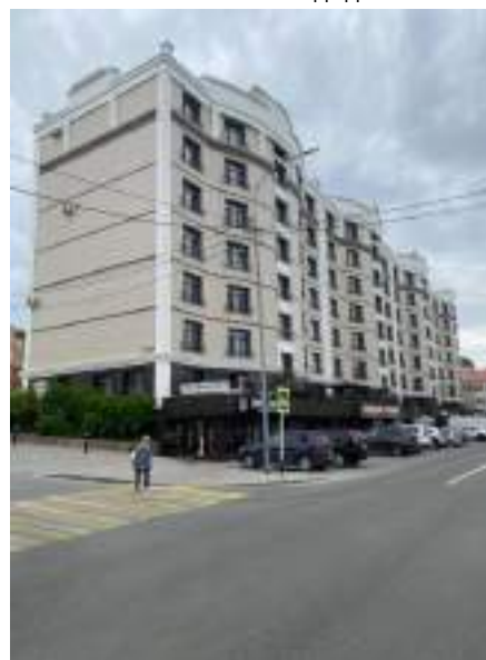
Фото 4. Внешний вид здания
