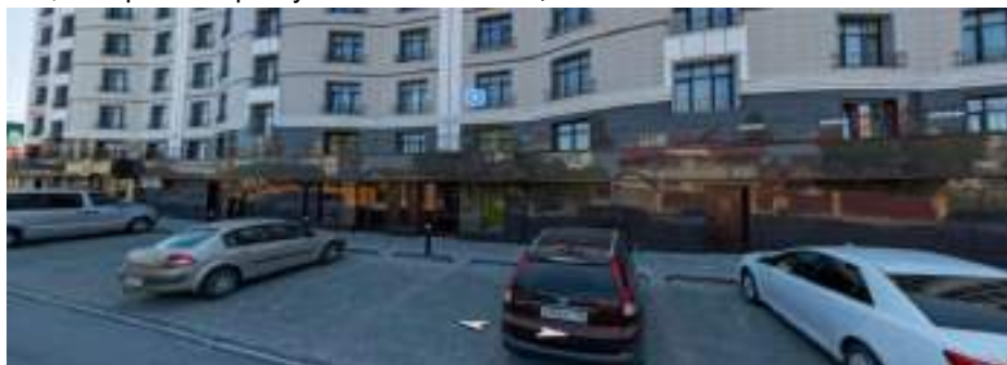
Фото 21 Общий вид оцениваемых помещений.
