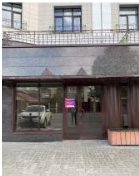
Фото 9. Вид на помещение 1003 с улицы
