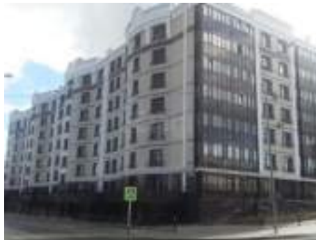
Фото 22 Общий вид жилого дома, в котором находятся оцениваемые помещения
