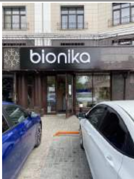
Фото 12. Вид на помещение 1004 с улицы
