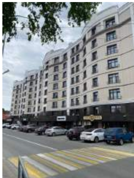
Фото 2. Внешний вид здания
