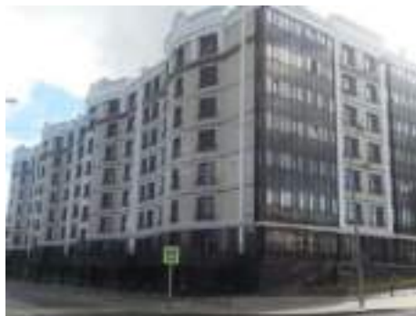
Фото 22 Общий вид жилого дома, в котором находятся оцениваемые помещения
