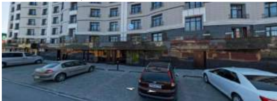
Фото 21 Общий вид оцениваемых помещений.
