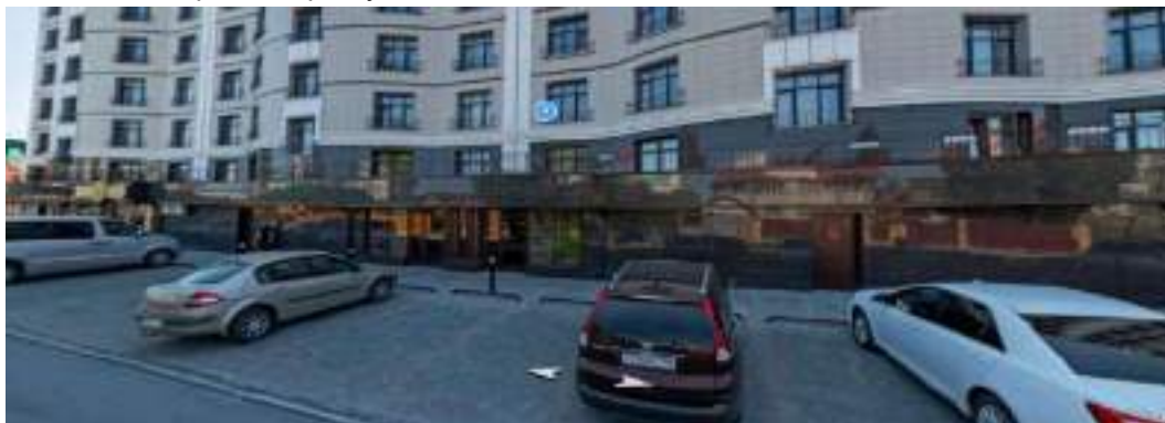
Фото 19 Общий вид оцениваемых помещений.
