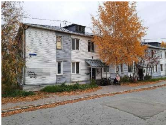
Фото. 1. Жилой дом по адресу: г. Ханты-Мансийск, ул. Мира, д. 23
