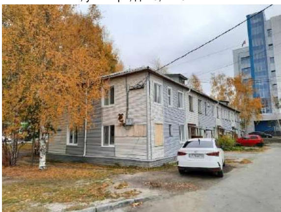
Фото. 11. Жилой дом по адресу: г. Ханты-Мансийск, ул. Мира, д. 25
