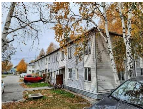
Фото. 14. Жилой дом по адресу: г. Ханты-Мансийск, ул. Мира, д. 25
