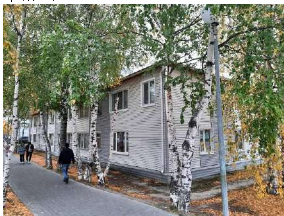
Фото. 12. Жилой дом по адресу: г. Ханты-Мансийск, ул. Мира, д. 25
