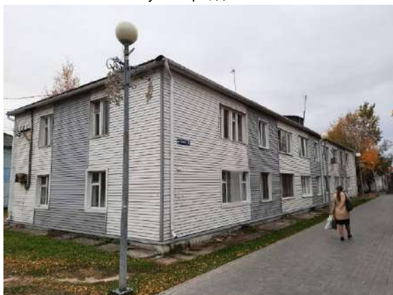
Фото. 3. Жилой дом по адресу: г. Ханты-Мансийск, ул. Мира, д. 23
