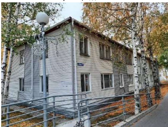
Фото. 13. Жилой дом по адресу: г. Ханты-Мансийск, ул. Мира, д. 25
