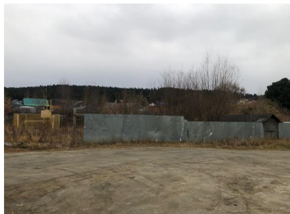
Фото 8. Общий вид земельного участка с кадастровым номером 86:12:0101089:815.
