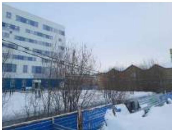
Фото 12. Общий вид объекта незавершенного строительства кадастровый номер: 86:12:0101059:30
