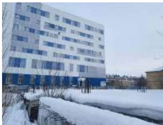
Фото 7. Общий вид объекта незавершенного строительства кадастровый номер: 86:12:0101059:30
