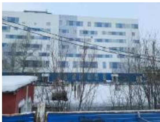
Фото 11. Общий вид объекта незавершенного строительства кадастровый номер: 86:12:0101059:30
