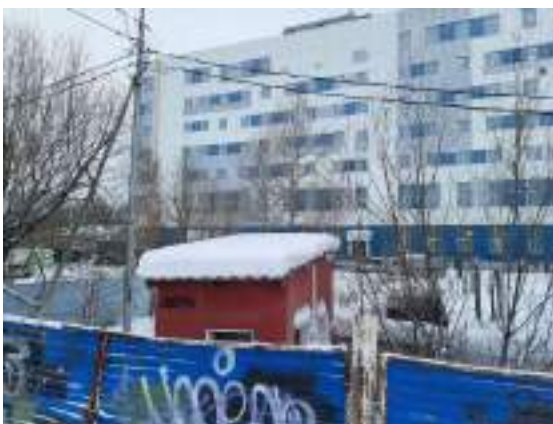
Фото 13. Общий вид объекта незавершенного строительства кадастровый номер: 86:12:0101059:30
