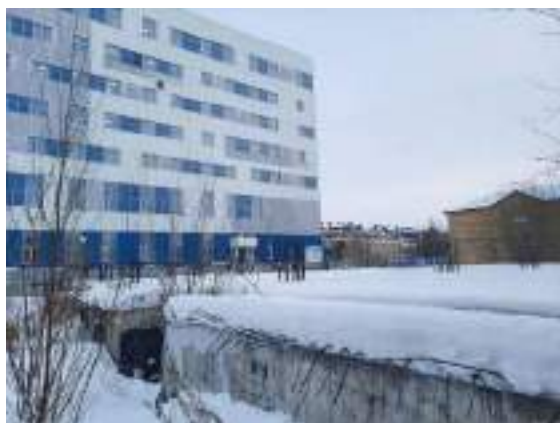
Фото 10. Общий вид объекта незавершенного строительства кадастровый номер: 86:12:0101059:30
