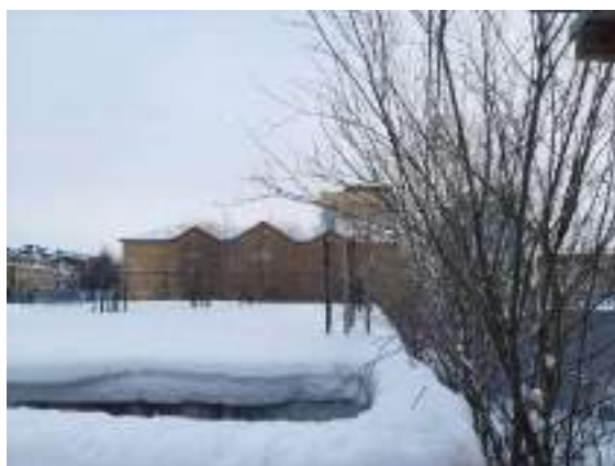
Фото 8. Общий вид объекта незавершенного строительства кадастровый номер: 86:12:0101059:30
