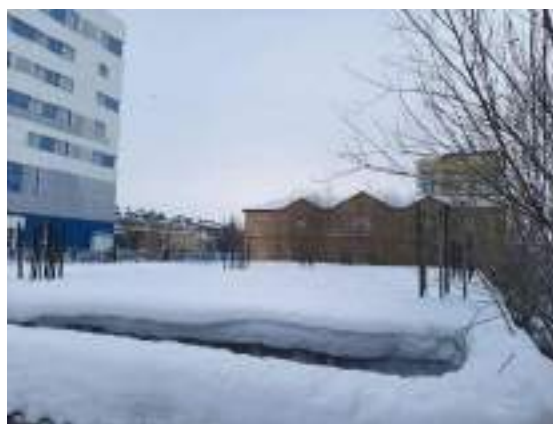
Фото 9. Общий вид объекта незавершенного строительства кадастровый номер: 86:12:0101059:30
