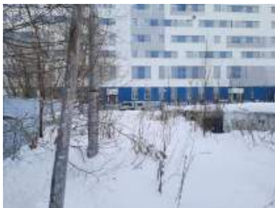
Фото 6. Общий вид объекта незавершенного строительства кадастровый номер: 86:12:0101059:30
