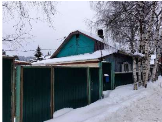
Фото 2. Общий вид жилого дома
