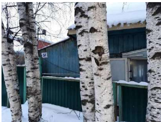
Фото 3. Общий вид жилого дома
