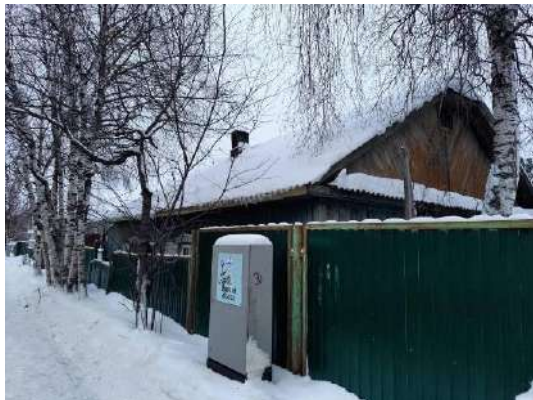
Фото 1. Общий вид жилого дома
