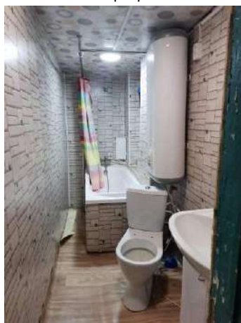
Фото. 8. Внутренний вид оцениваемой квартиры
