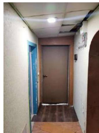
Фото. 7. Внутренний вид оцениваемой квартиры
