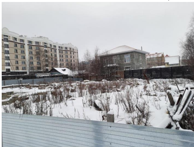
Фото 3. Общий вид земельного участка с кадастровым номером 86:12:0101058:6.
