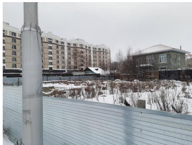
Фото 2. Общий вид земельного участка с кадастровым номером 86:12:0101058:6.
