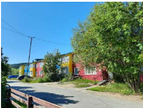
Фото. 5. Жилой дом по адресу: г. Ханты-Мансийск, ул. Чехова, д. 62
