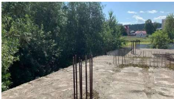
Фото 7. Общий вид объекта незавершенного строительства кадастровый номер: 86:12:0101059:30
