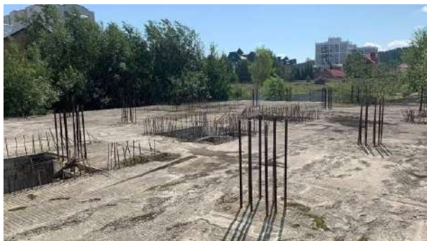
Фото 17. Общий вид объекта незавершенного строительства кадастровый номер: 86:12:0101059:30
