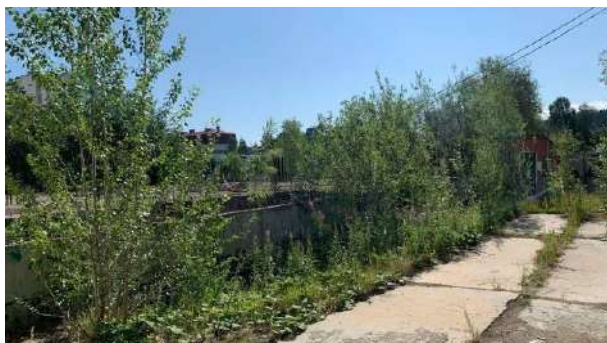
Фото 11. Общий вид объекта незавершенного строительства кадастровый номер: 86:12:0101059:30
