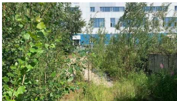
Фото 16. Общий вид объекта незавершенного строительства кадастровый номер: 86:12:0101059:30
