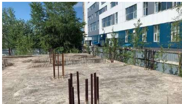
Фото 8. Общий вид объекта незавершенного строительства кадастровый номер: 86:12:0101059:30
