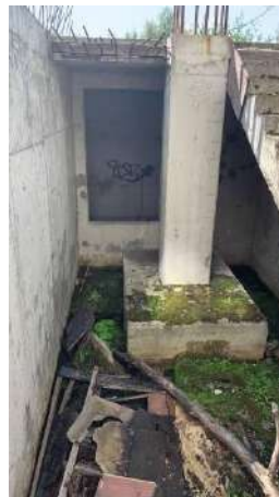
Фото 18. Общий вид объекта незавершенного строительства кадастровый номер: 86:12:0101059:30
