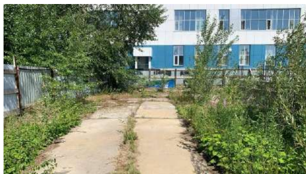
Фото 14. Общий вид объекта незавершенного строительства кадастровый номер: 86:12:0101059:30
