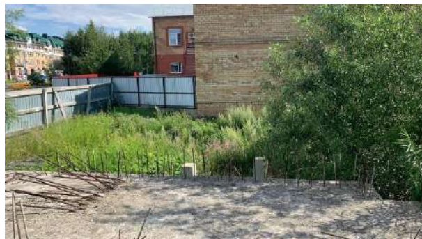
Фото 10. Общий вид объекта незавершенного строительства кадастровый номер: 86:12:0101059:30
