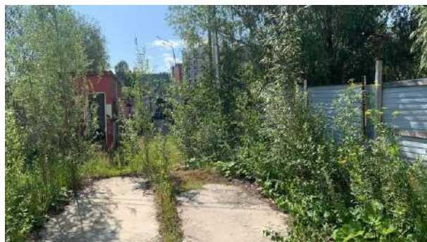
Фото 12. Общий вид объекта незавершенного строительства кадастровый номер: 86:12:0101059:30
