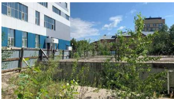
Фото 15. Общий вид объекта незавершенного строительства кадастровый номер: 86:12:0101059:30
