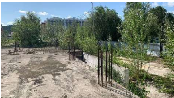
Фото 13. Общий вид объекта незавершенного строительства кадастровый номер: 86:12:0101059:30
