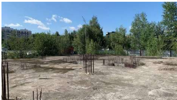
Фото 9. Общий вид объекта незавершенного строительства кадастровый номер: 86:12:0101059:30
