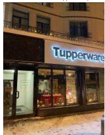
Фото 5. Внешний вид помещений
