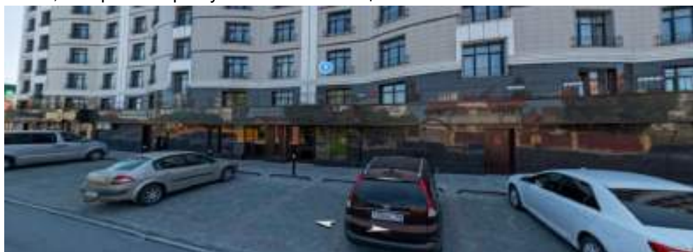
Фото 21 Общий вид оцениваемых помещений.
