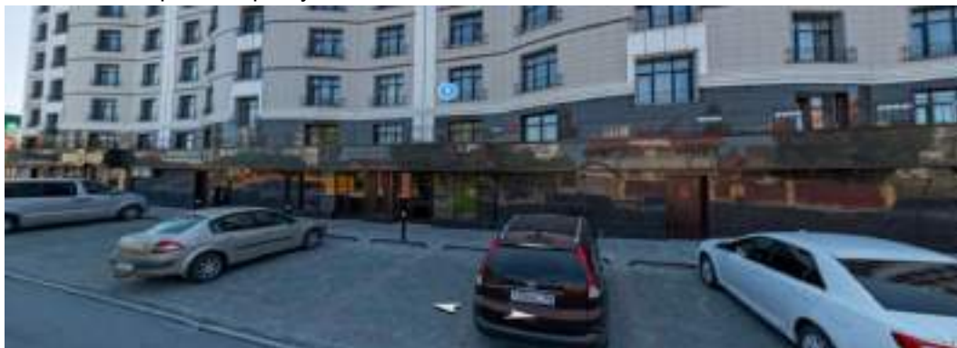
Фото 19 Общий вид оцениваемых помещений.
