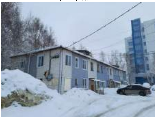
Фото. 20. Жилой дом по адресу: г. Ханты-Мансийск, ул. Мира, д. 25
