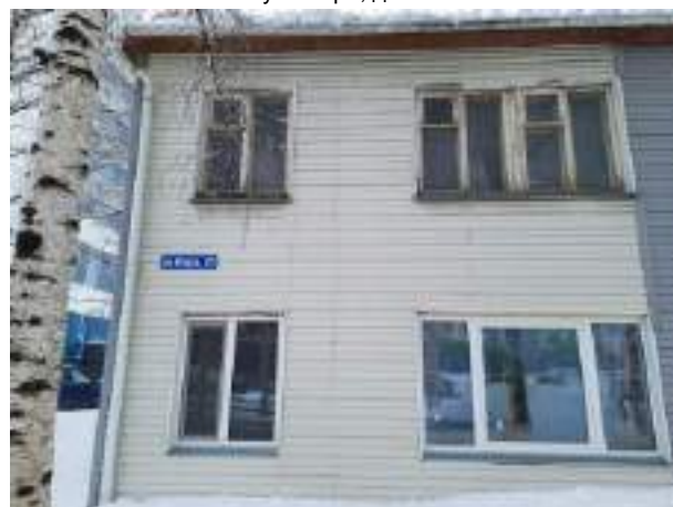
Фото. 21. Жилой дом по адресу: г. Ханты-Мансийск, ул. Мира, д. 25
