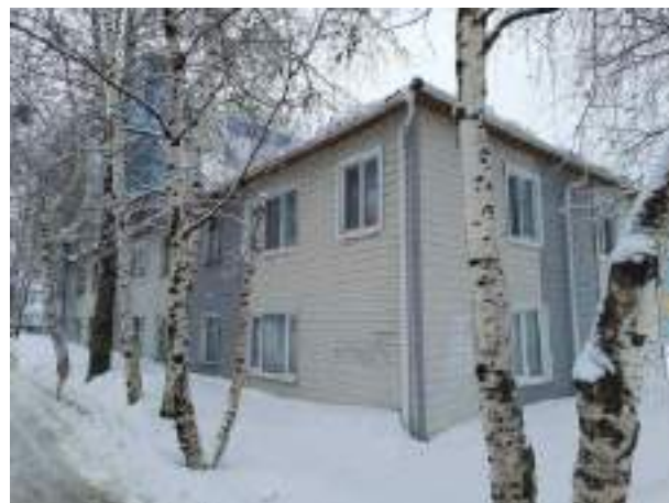
Фото. 19. Жилой дом по адресу: г. Ханты-Мансийск, ул. Мира, д. 25
