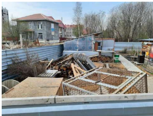
Фото 6. Общий вид земельного участка с кадастровым номером 86:12:0101058:5.
