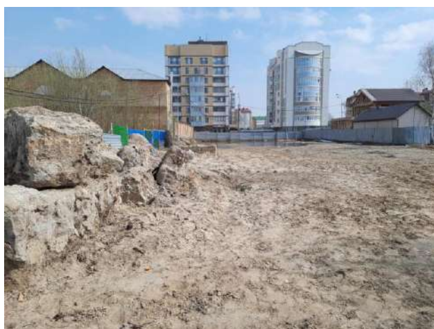
Фото 1. Общий вид земельного участка с кадастровым номером 86:12:0101059:14.
