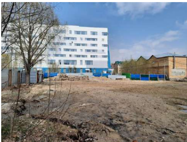
Фото 5. Общий вид земельного участка с кадастровым номером 86:12:0101059:14.
