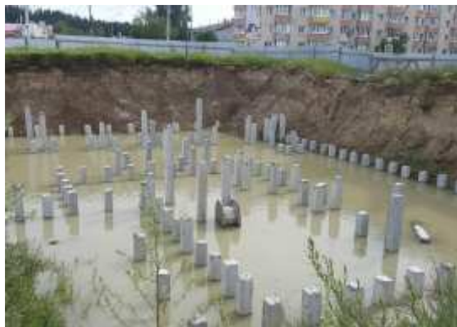
Фото 6. Внешний вид строящегося жилого дома
