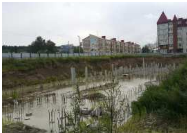
Фото 4. Внешний вид строящегося жилого дома
