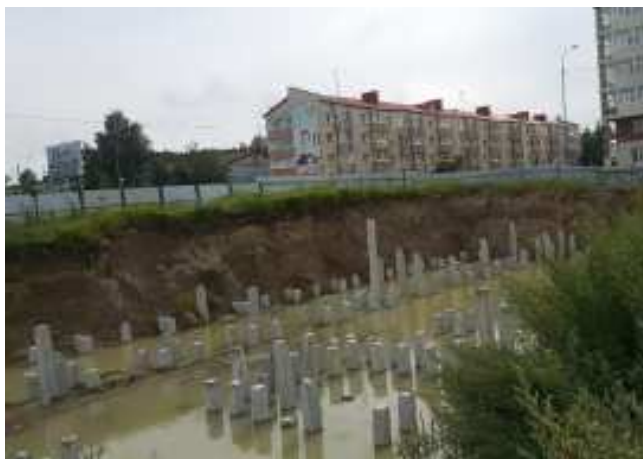
Фото 5. Внешний вид строящегося жилого дома
