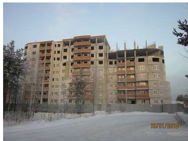
Фото 4. Внешний вид строящегося жилого дома
