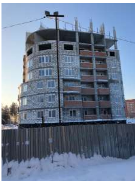
Фото 5. Внешний вид строящегося жилого дома
