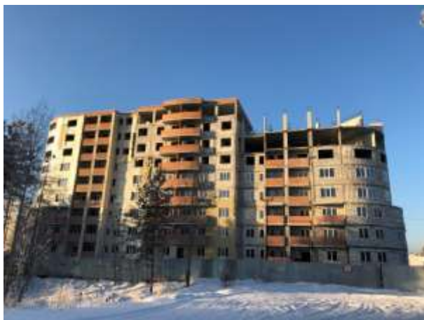
Фото 1. Внешний вид строящегося жилого дома
