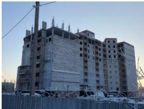
Фото 2. Внешний вид строящегося жилого дома
