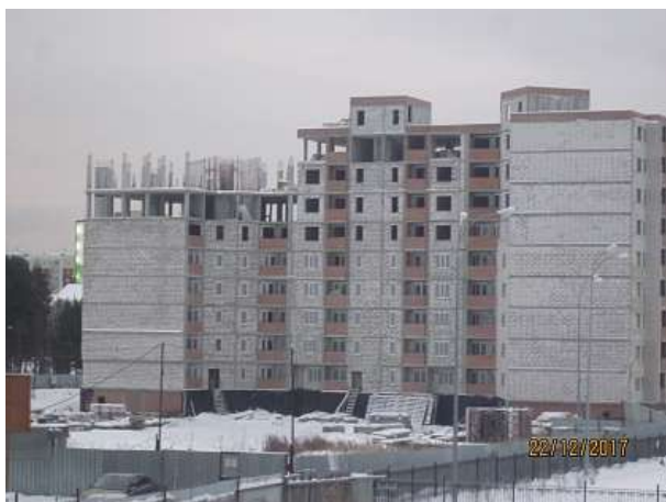
Фото 3. Внешний вид строящегося жилого дома
