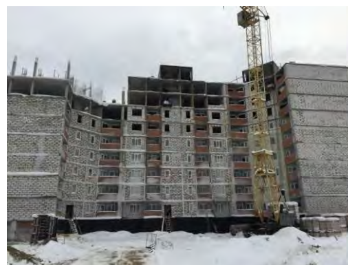
Фото 4. Внешний вид строящегося жилого дома
