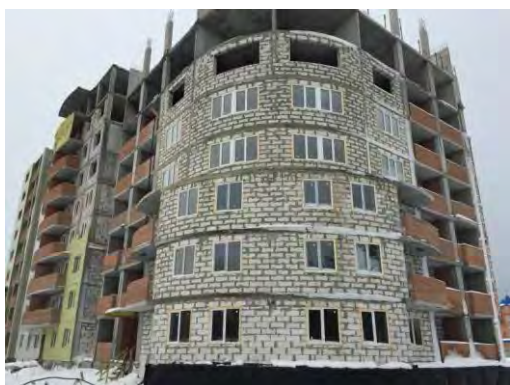
Фото 3. Внешний вид строящегося жилого дома
