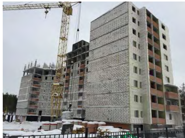
Фото 2. Внешний вид строящегося жилого дома
