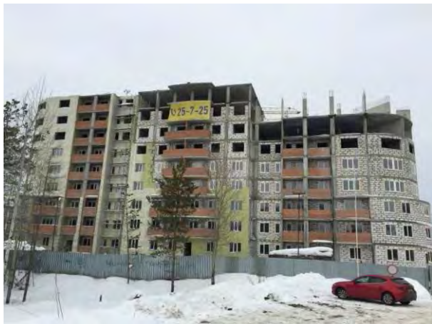
Фото 1. Внешний вид строящегося жилого дома
