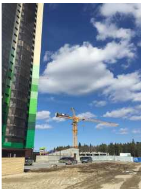
Фото 1. Вид площадки строительства дома
