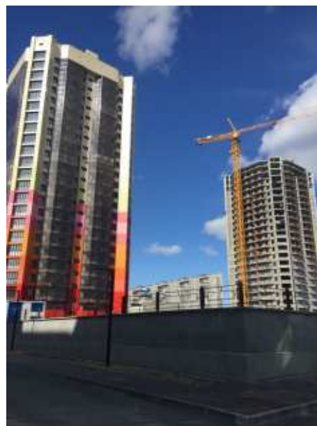
Фото 2. Вид площадки строительства дома
